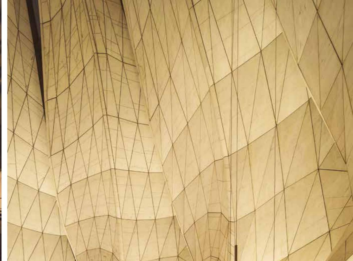
As nove pétalas que compõem o volume do edifício se desenvolvem em torno de um eixo central. As fachadas são constituídas por uma estrutura metálica revestida externamente por lâminas de vidro fundido, desenhadas para o projeto, e internamente por mármore português branco translúcido. A luz diurna penetra no interior do templo pelas janelas, que se desenvolvem entre as nove pétalas, e através da dupla camada translúcida formada pelas superfícies de vidro e de mármore.
